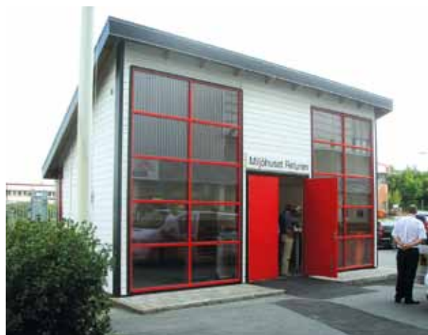
Källsorteringshus hos Renova, Sävénäs, Göteborg
