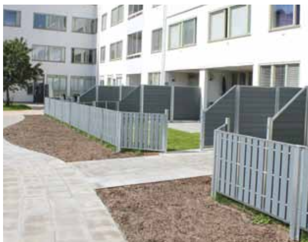
Renovering av uteplatser vid marklägenheter, Lertagsgatan, Örebro.
